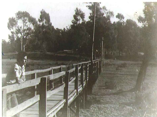
El Puente de Palo, construido por los propios vecinos a inicios de los años 70.
