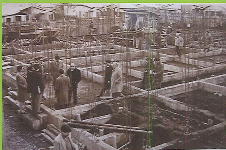
Una imagen de la construcción del consultorio Paillihue, en 1993.
