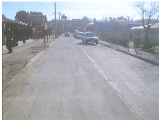
Calle San Miguel actualmente, luego de su pavimentación.
