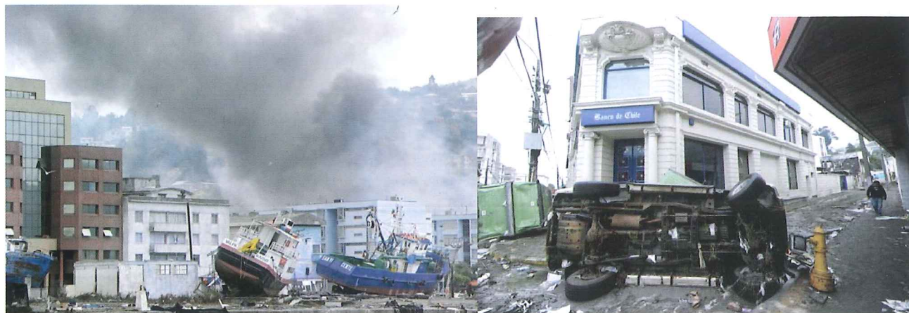
Imágenes de los daños en Talcahuano
