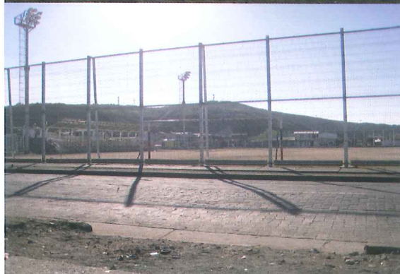
Obras al 18 de enero de 2008 y estado actual de la cancha.
