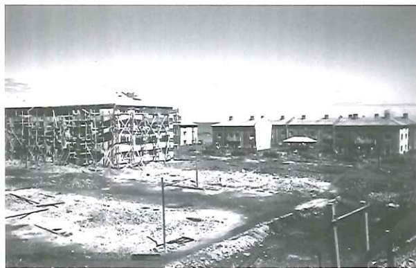
Construcción de edificios colectivos hacia 1943.
