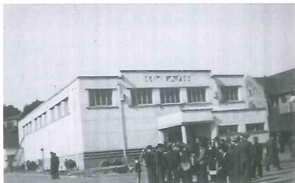
El Gimnasio antiguo, antes de su remodelación.
