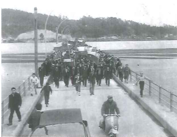
El puente sobre el Bío Bío fue llenado de extremo a extremo en la marcha de los mineros.
