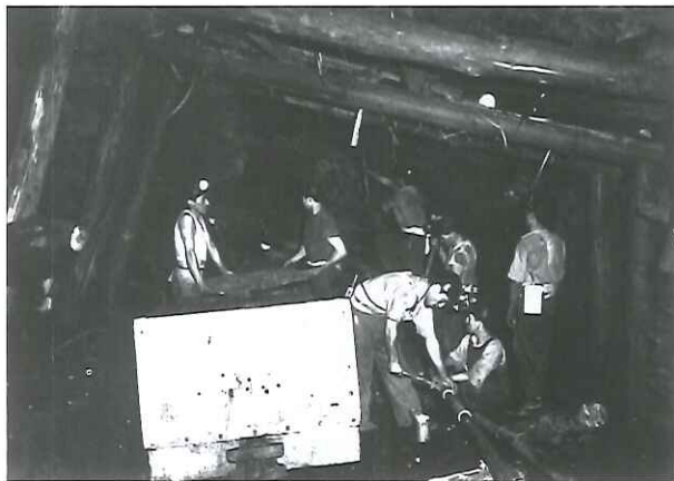
Interior mina, frente de extracción hacia 1950.
