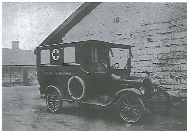
Antiguo "coche ambulancia", socorría las emergencias en la mina.
