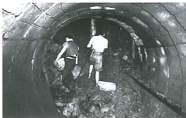
Derrumbe interior mina.
