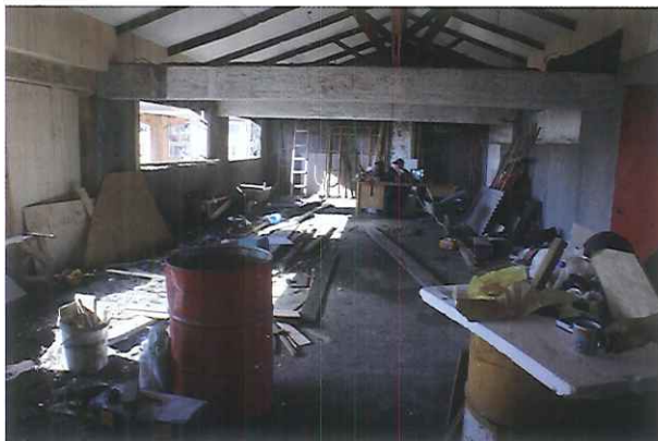
Mejoramiento sede JJVV. N° 11.
