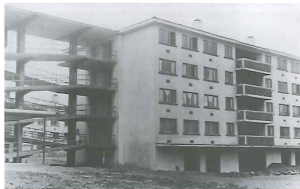
Fachada de los edificios colectivos hacia 1953.
