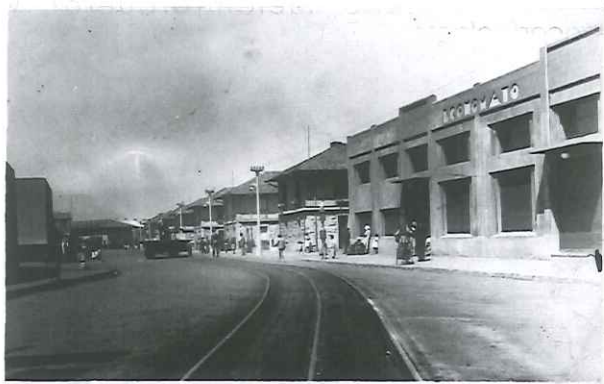
"Economato" remodelado. De fondo, los Pabellones.
