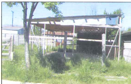
Estado actual del edificio.
