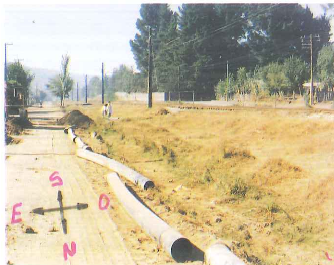
Arreglos en calle O'Higgins, fotos recopiladas entre vecinos.
