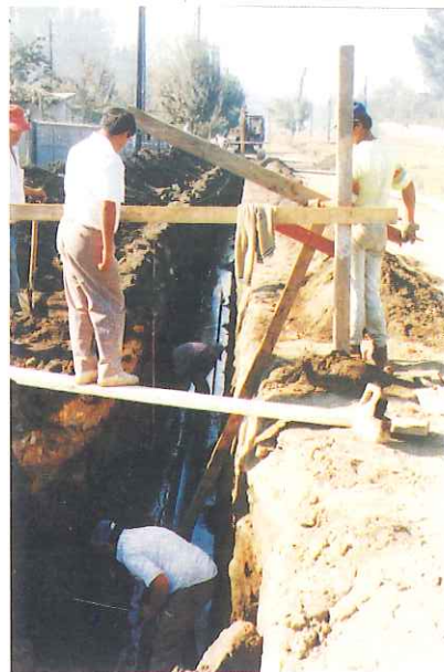
Arreglos en calle O'Higgins, fotos recopiladas entre vecinos.
